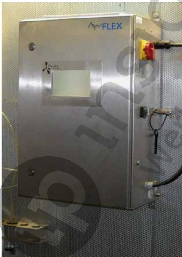
Kontrollierte Prozessführung mittels Gasanalysegerät (Foto: Awite)
